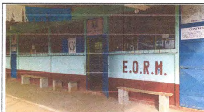
FOTO 10 MANTENIMIENTO DE PUERTAS Y SUSTITUCION DE PISO A CERAMICA
