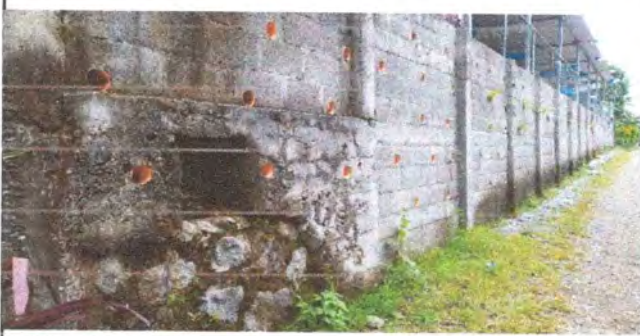
FOTO 3. COLOCACION DE DOS COLUMNAS DE SOPORTE DE TRES METROS DE ALTURA PARA EVITAR EL COLAPSO DEL MURO DE CONTENCIÓN.
