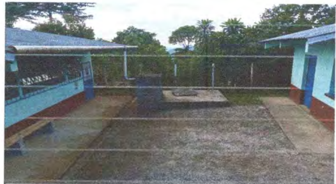
FOTO 4 ENTECHADO DEL CORREDOR DE AULAS
