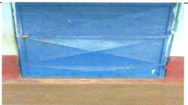
FOTO 9. MANTENIMIENTO DE PUERTAS
