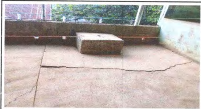
FOTO 2 FRENTE DEL ESCENARIO POR DONDE EL PATIO SE COLOCARA DOS COLUMNAS DE SOPORTE
