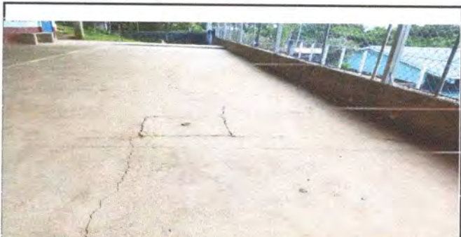
FOTO 5. REPARACION DE PIZO CON TORTA DE CEMENTO EN EL AREA DEL CORREDOR YA QUE PRESENTA GRITAS EN SU MAGNITUD
