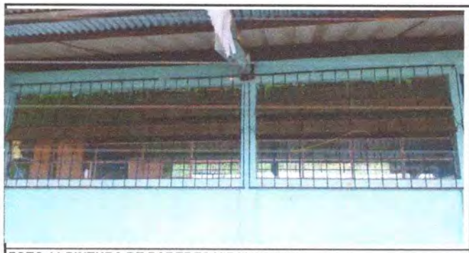
FOTO 11 PINTURA DE PAREDES Y BALCONES
