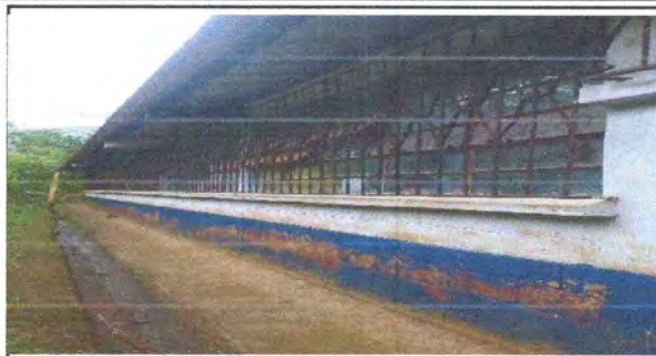
FOTO 8. SUSTITUCION DE PINTURA EN PAREDES DE TODO EL EDIFICIO ESCOLAR Y BALCONES
